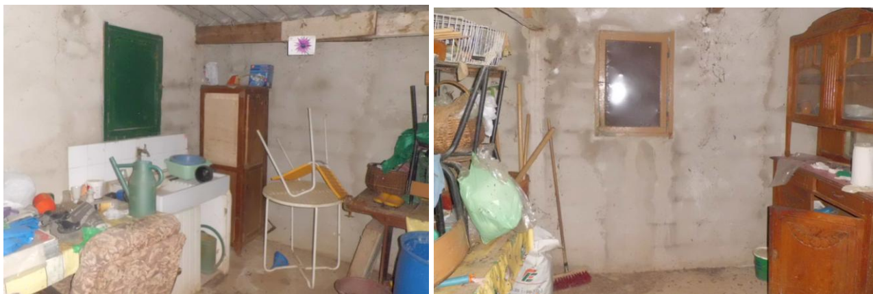
Figure 24 : Vue intérieure du bâtiment (Safege, 2014)
