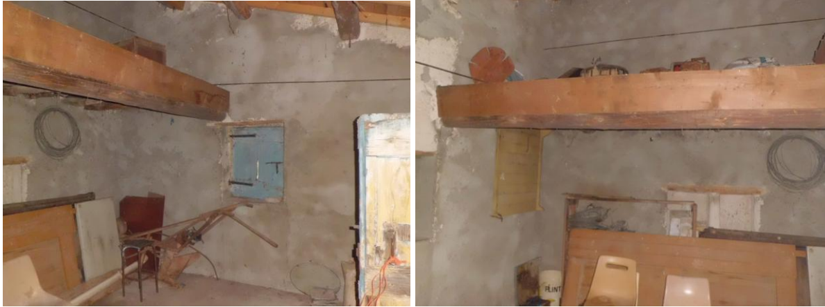
Figure 32 : Vue intérieure du bâtiment (Safège, 2014)
