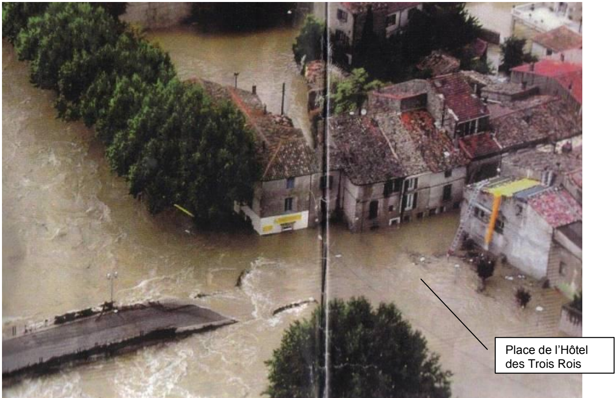
Figure 12 : Photographie aérienne des inondations observées à Quissac au droit de la place de l'Hôtel des Trois Rois lors de l'évènement des 8 et 9 septembre 2002 (source : Syndicat du Vidourle)
