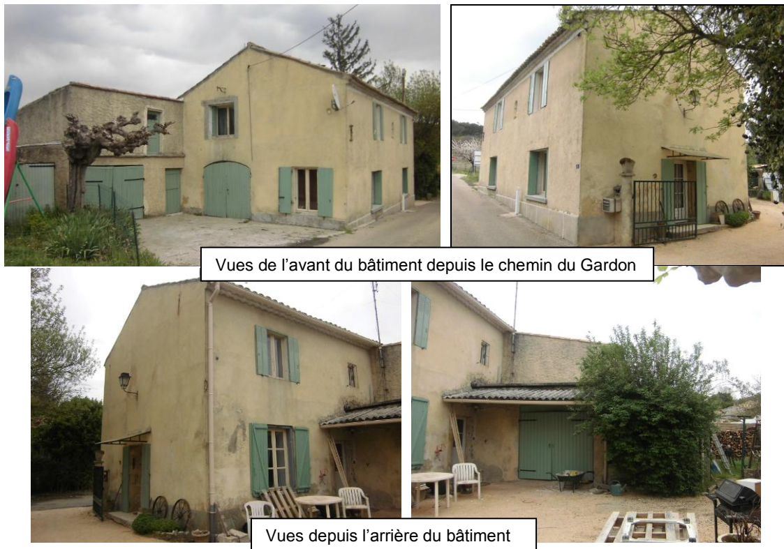
Figure 60 : Vues du bien concerné (photos prises lors de la visite du 03 avril 2014, Safège)
