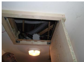
Figure 56 : Illustration de la trappe d'accès aux combles
