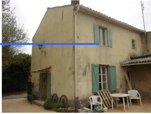
Figure 62 : Illustration de la hauteur de submersion observée au droit de la propriété lors de la crue de septembre 2002
