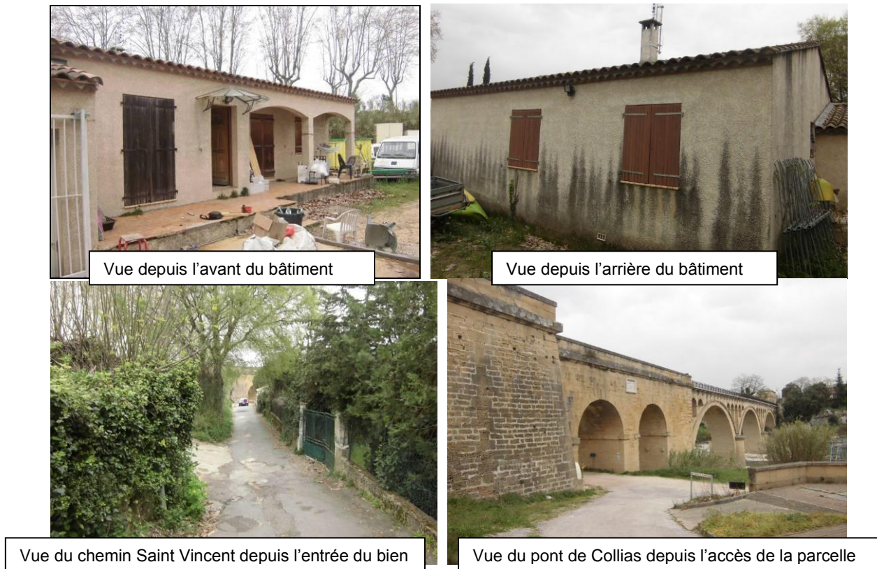
Figure 54 : Vues du bien concerné (photos prises lors de la visite du 03 avril 2014, Safège)
