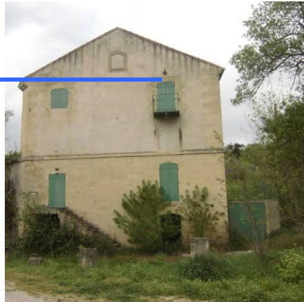
Figure 34 : Illustration de la hauteur de submersion observée au droit de la propriété lors de la crue de septembre 2002
