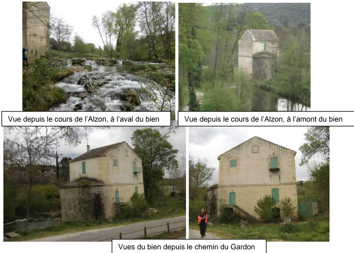
Figure 32 : Vues du bien concerné (photos prises lors de la visite du 03 avril 2014, Safège)
