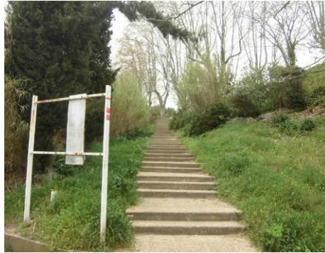
Figure 57 : Illustration des escaliers permettant de rejoindre le pont de la RD3 depuis les abords du bien COL39
