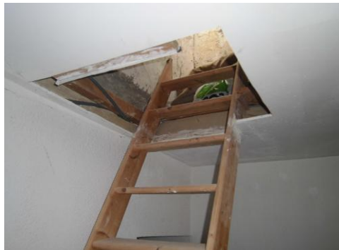
Figure 64 : Illustration de l'accès aux combles
