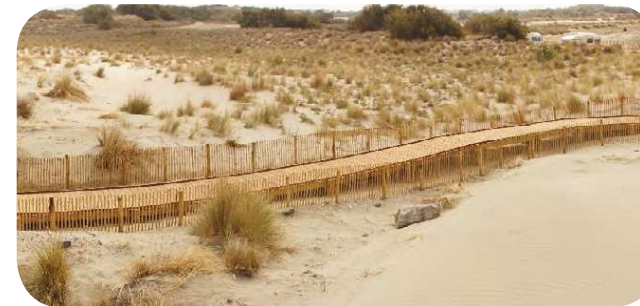
Exemple de platelage bois en milieu dunaire (Plage de BEAUDUC)
