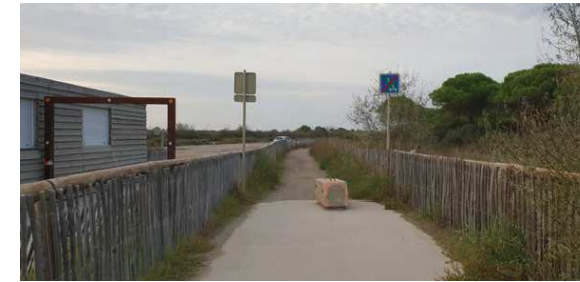
Cloture bois RONDINO pin classe IV ganivelle de châtaignier, enrobé coloré puis sable...
