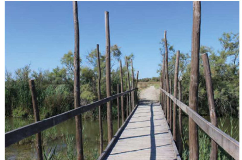
Exemple de platelage bois en milieu naturel (sentier de la Marette, Maison du grand site Camargue Gardoise à Aigues Mortes) :
