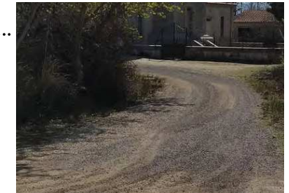
Sol en place compacté et chaux
