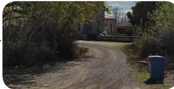
Circulations autour du phare : Sol en place compacté et chaux
