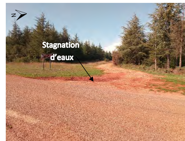
Photographies : GAUCHE : Arrivée des eaux de la piste forestière et de la RD238 qui s'accumulent le long de la route ; DROITE : Tranchée et zone d'infiltration en bordure de la RD238
