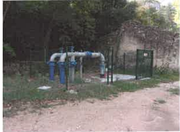
Les deux nouveaux forages
