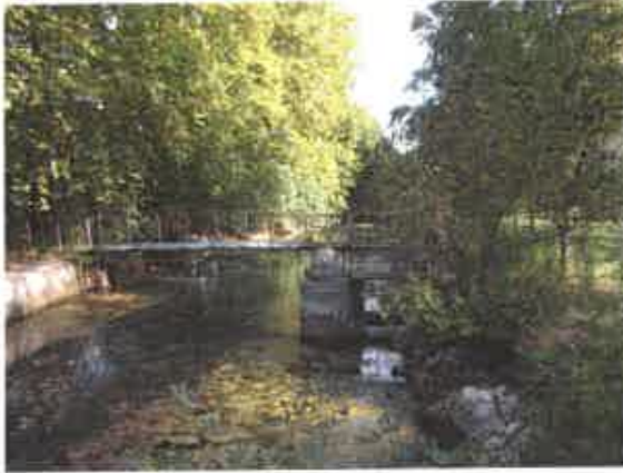
Ancien dispositif de pompage
