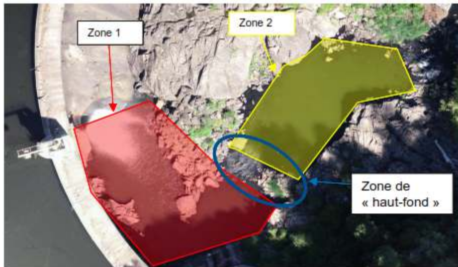
Figure 39 : Zone d'intervention au droit du barrage des Cambous
