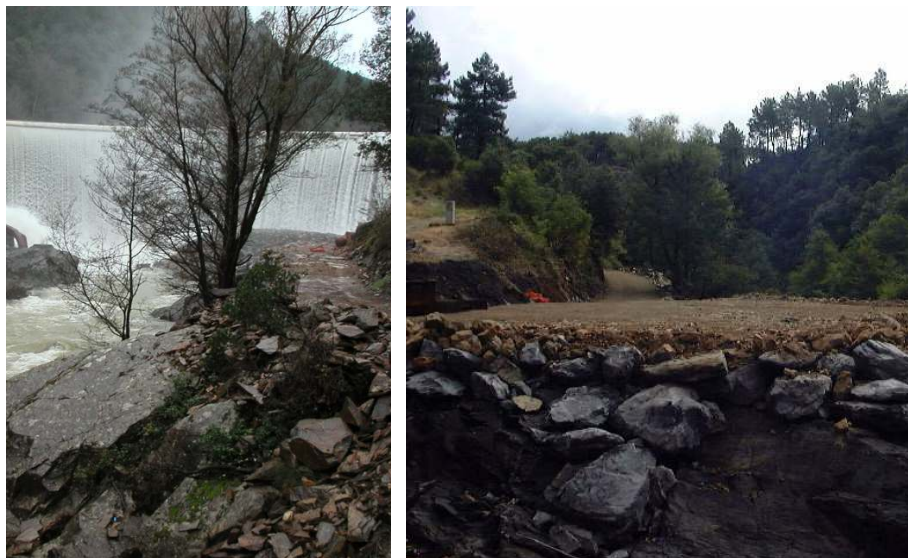
Photographie 13 : Plateforme et piste d'accès créer pour les travaux de 2002 / 2003
