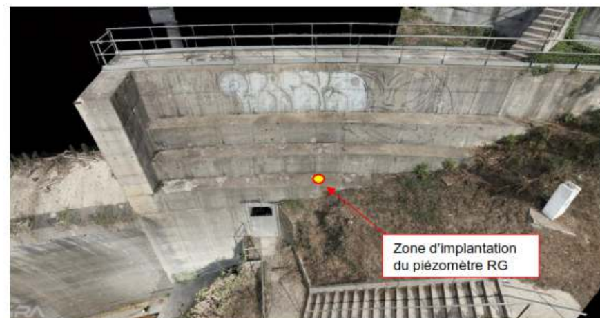
Figure 27 : Drains actuellement observables au droit du massif de butée du barrage des Cambous
