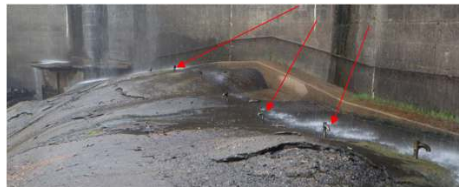
Figure 27 : Drains actuellement observables au droit du massif de butée du barrage des Cambous
