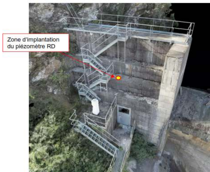
Figure 25 : Implantation du piézomètre sur la culée rive droite
