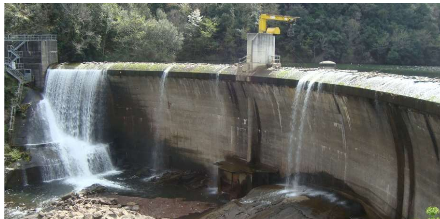
Photographie 3 : Le barrage des Cambous (avril 2019)
