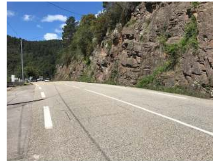
RN106 au droit du barrage vers Mendé
