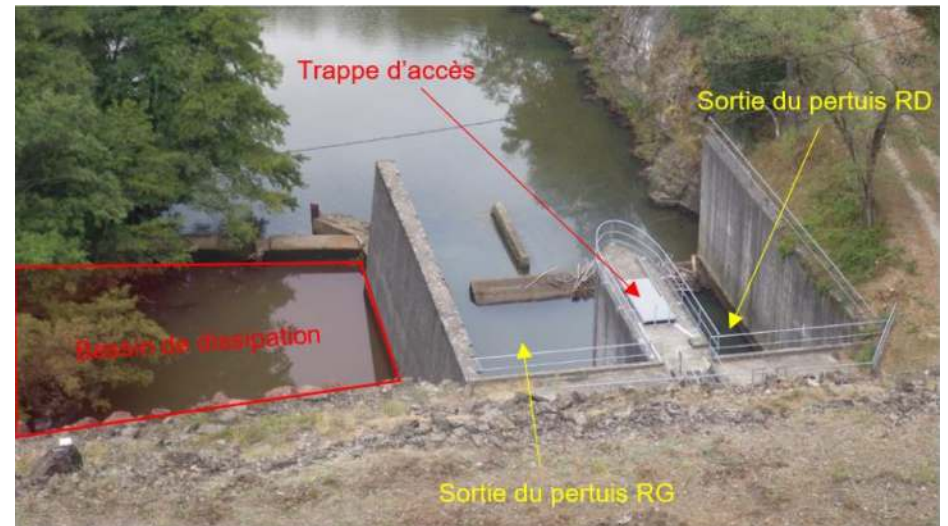
Photographie 9 : Chambre de restitution aval, vue depuis le couronnement du barrage
