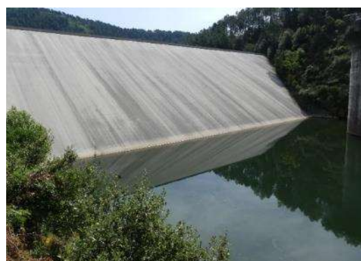
Barrage nord côté amont
