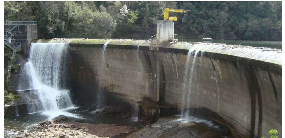
Photographie 3 : Le barrage des Cambous (avril 2019)
