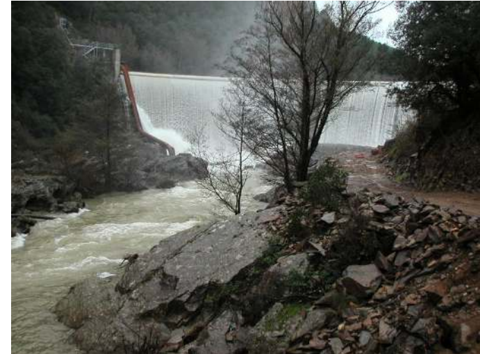
Photographie 14 : Surverse du barrage lors des travaux de 2002 / 2003
