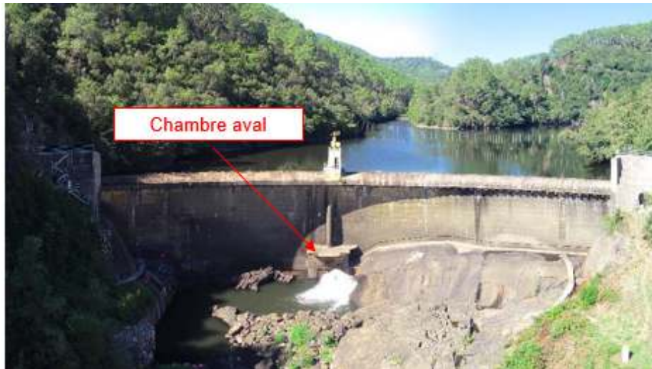
Figure 28 : Chambre aval du barrage des Cambous
