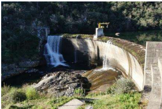
Barrage sud côté aval
