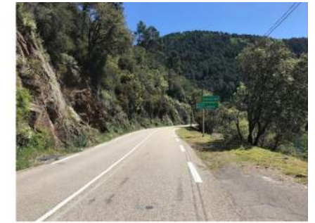
RN106 au droit du barrage vers Alès
