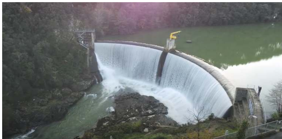
Photographie 4 : Le barrage des Cambous
