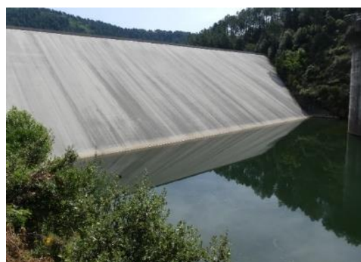
Barrage nord côté amont
