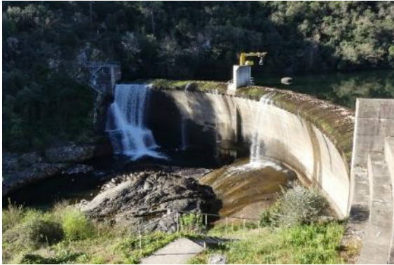
Barrage sud côté aval
