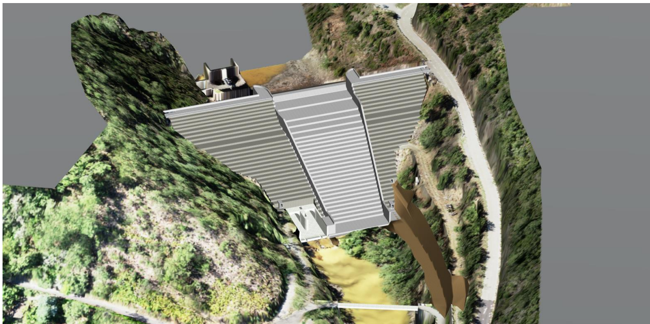
Figure 48 : Parement aval de l'ouvrage aménagé [Réf 20]
