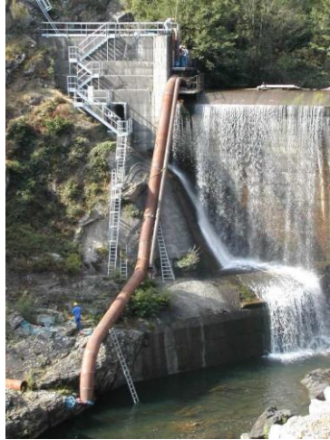
Figure 37 : Siphon lors des travaux de 2002-2003
