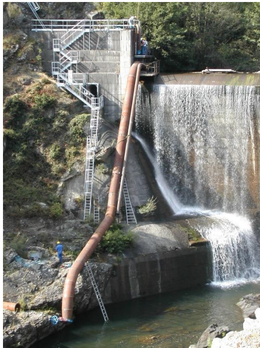
Figure 60: Siphon lors des travaux de 2002/2003
