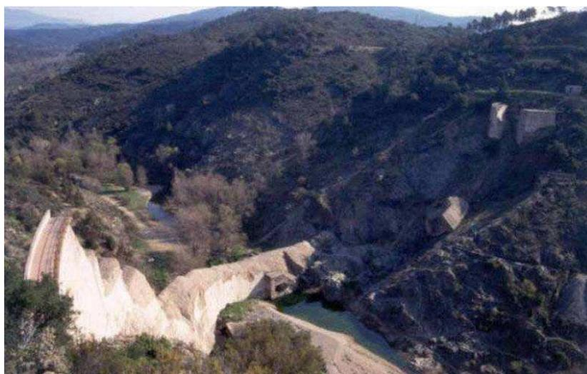
Figure 79 : Rupture du barrage de Malpasset (France, 1959)
