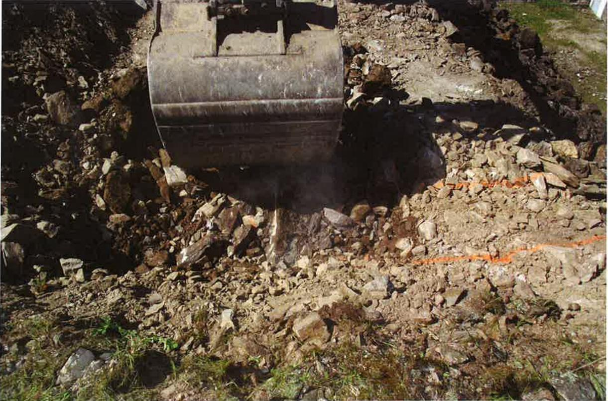
**Figure 9: début de l'excavation partie 1.5 -2.5m : la pelle racle l'arête d'un gros bloc**
