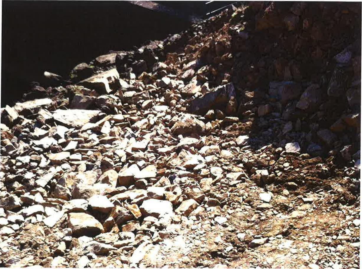
**Figure 15: zoom sur la zone dépourvue de fine en fond de fouille**
