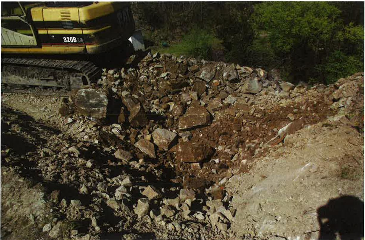
**Figure 10: zone crue avec de gros blocs en partie amont de la fouille**
