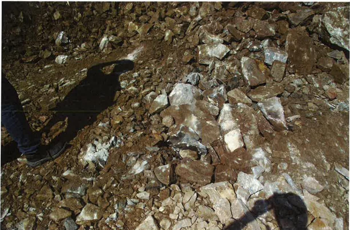
**Figure 7: fin de l'excavation de la partie superficielle 0-1.5m : présence en fond de fouille d'une zone crue composée de gros blocs**
