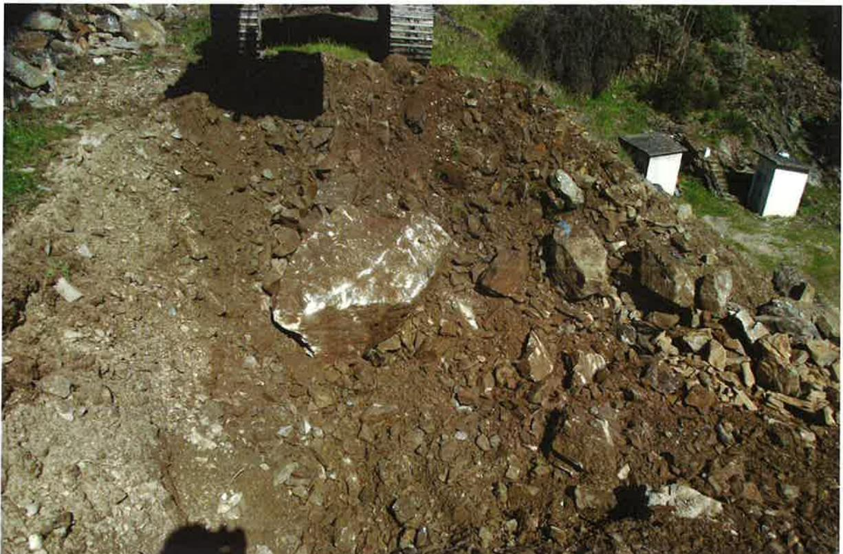
**Figure 5: présence de gros bloc à 1m de profondeur**
