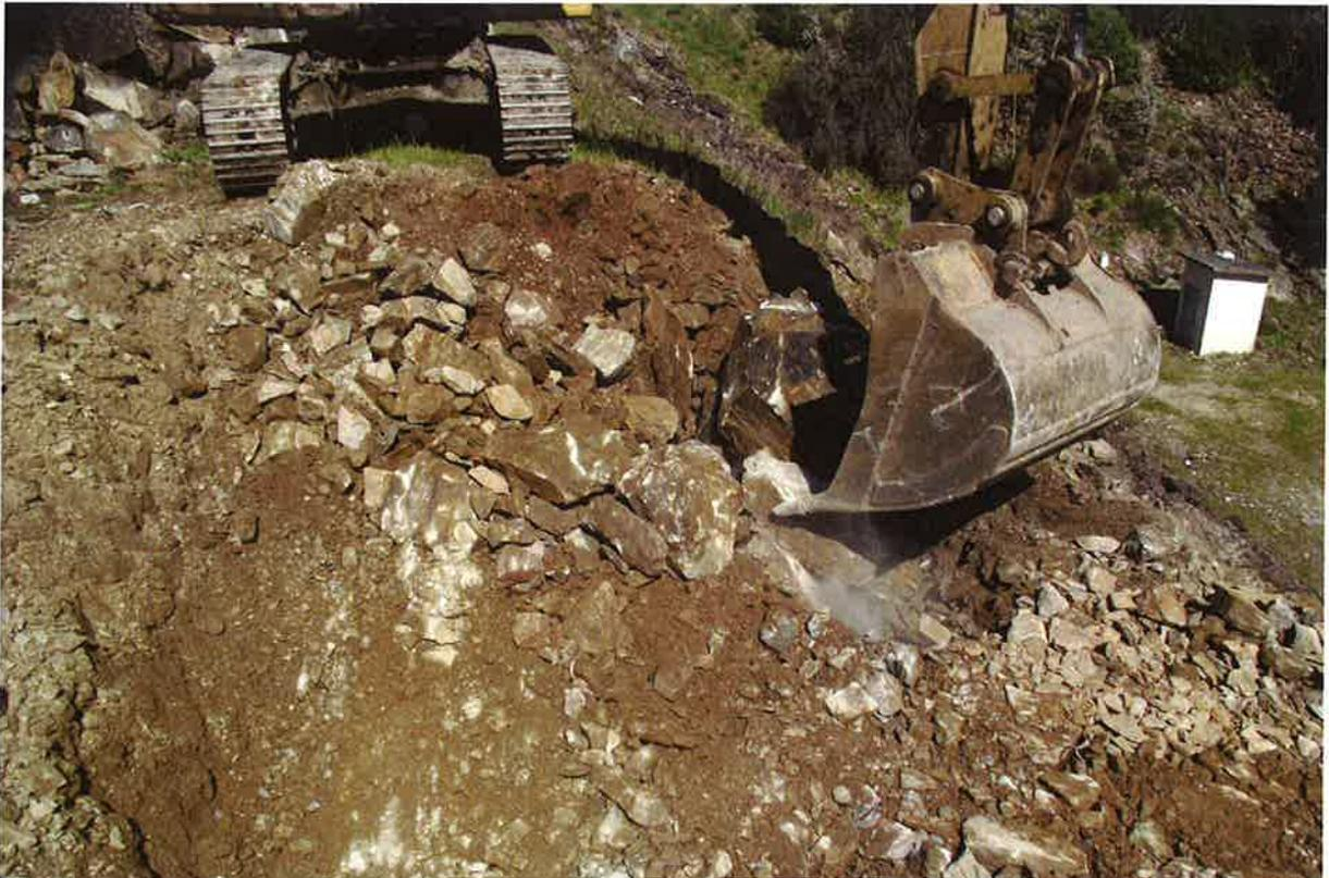
**Figure 6: zone crue dépourvue de fines et avec de gros blocs**
