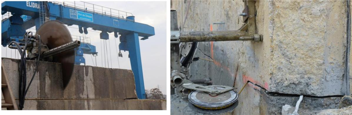
Figure 43 : Moyens de démolition soignée (scie murale et scie à câble diamanté)
