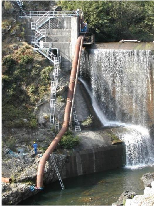
Figure 69: Siphon lors des travaux de 2002/2003
