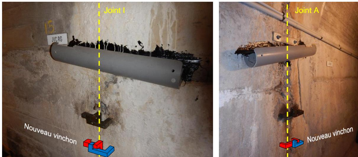
Figure 20: Vinchons existant et position des nouveaux vinchons au droit des joints A et I en galerie du barrage
