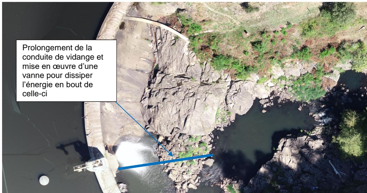
Figure 68: Solution de prolongement de la conduite de vidange pour gestion du débit réservé
