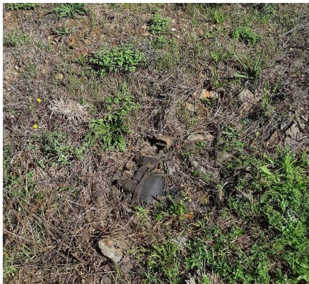
Figure 59: Conduite AEP à fleur de la surface sur l'embranchement à droite
