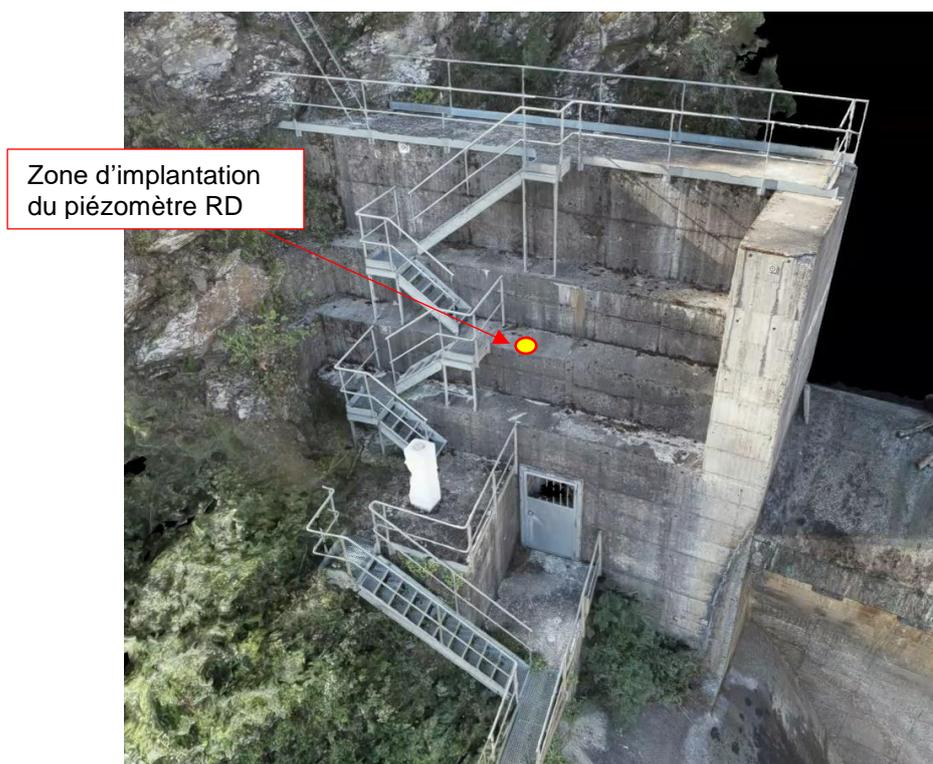
Figure 23 : Visualisation de l'implantation du piézomètre sur la culée rive droite (cote de forage : 228.00 m NGF)
