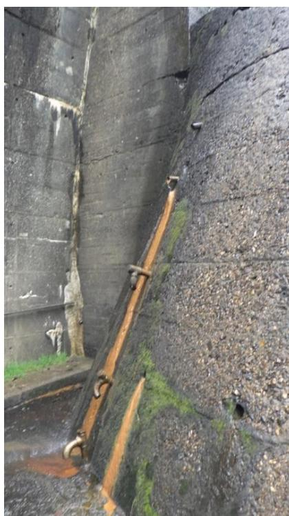
Figures 36 : Photos des drains existants en rive gauche (dont les têtes sont à modifier)
