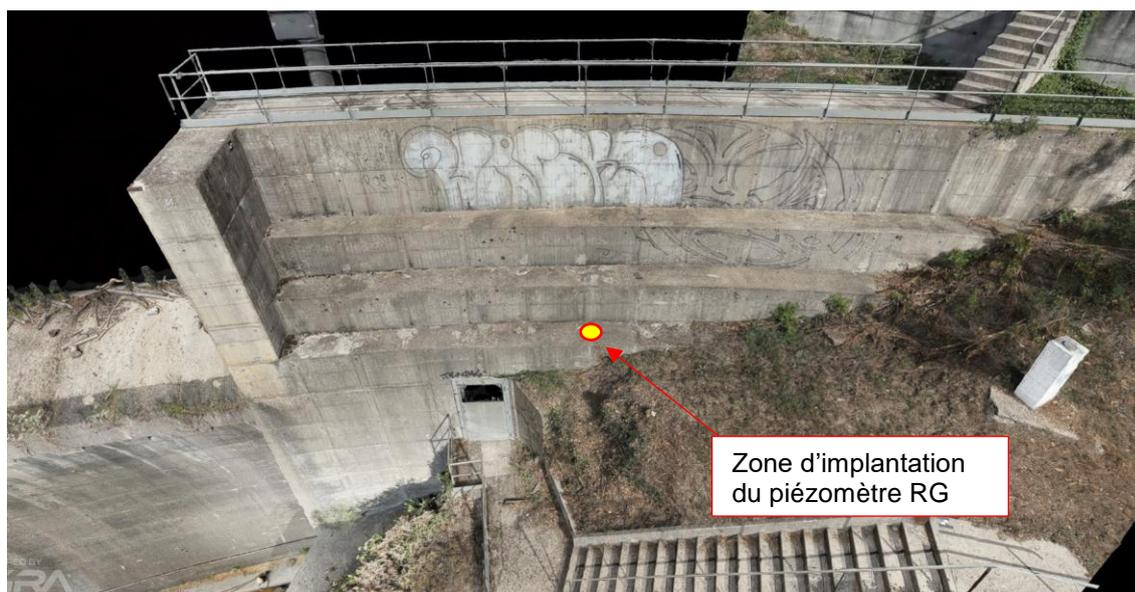
Figure 24 : Visualisation de l'implantation du piézomètre sur la culée rive gauche (cote de forage : 227.00 m NGF)
