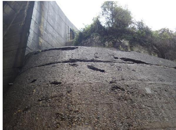
Figure 14: Photos récentes des désordres sur le massif rive gauche
