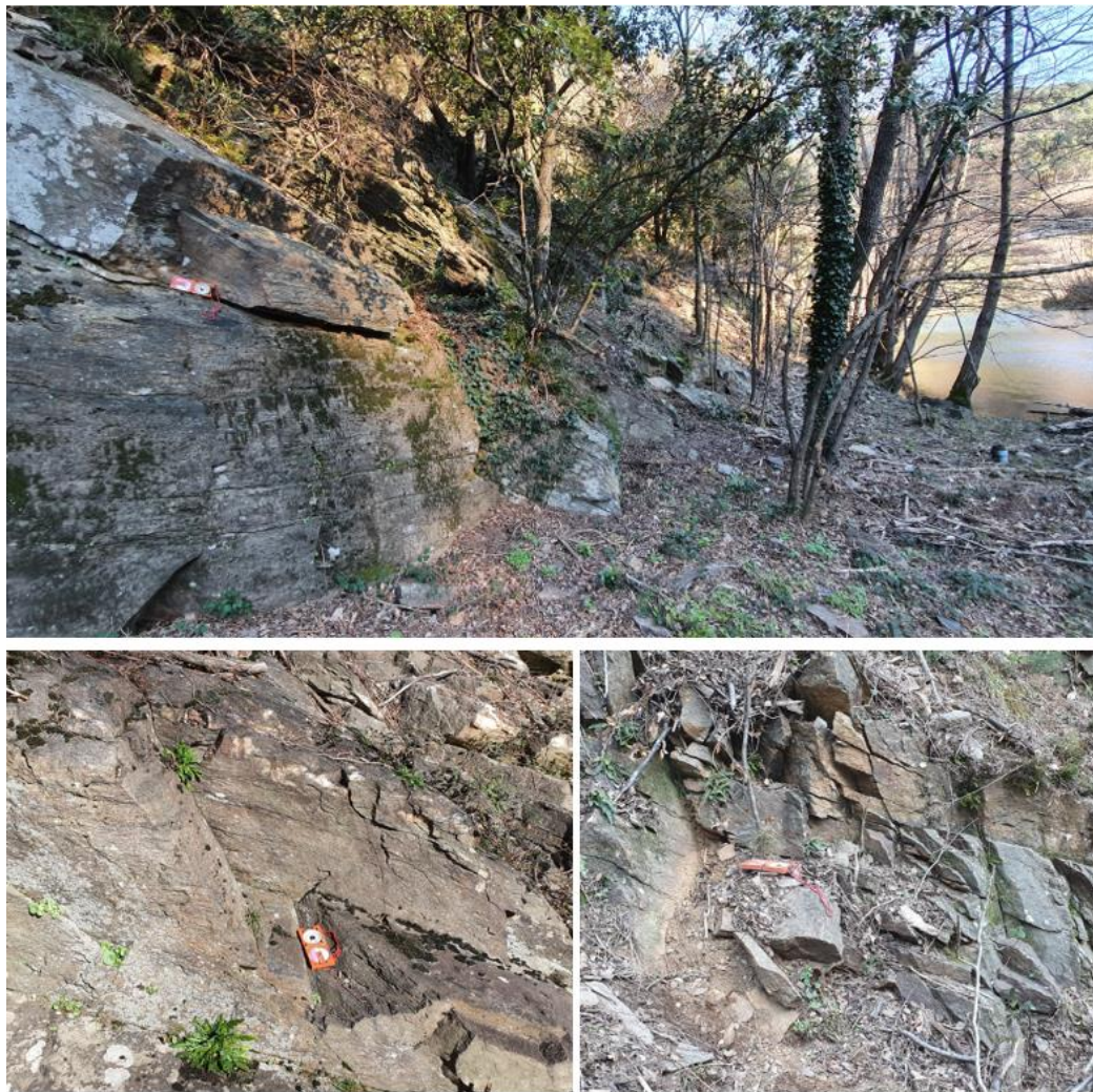
Figure 33 : Affleurements en pied de versant rive gauche à l'aval du barrage
