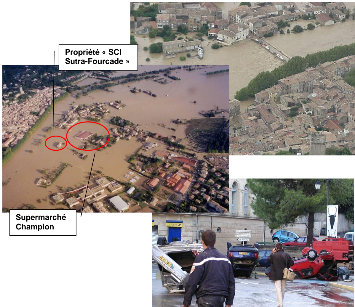
Figure 10 : Illustration des dégâts observés à Sommières lors de l'évènement des 8 et 9 septembre 2002 (source : forums.infoclimat.fr)
