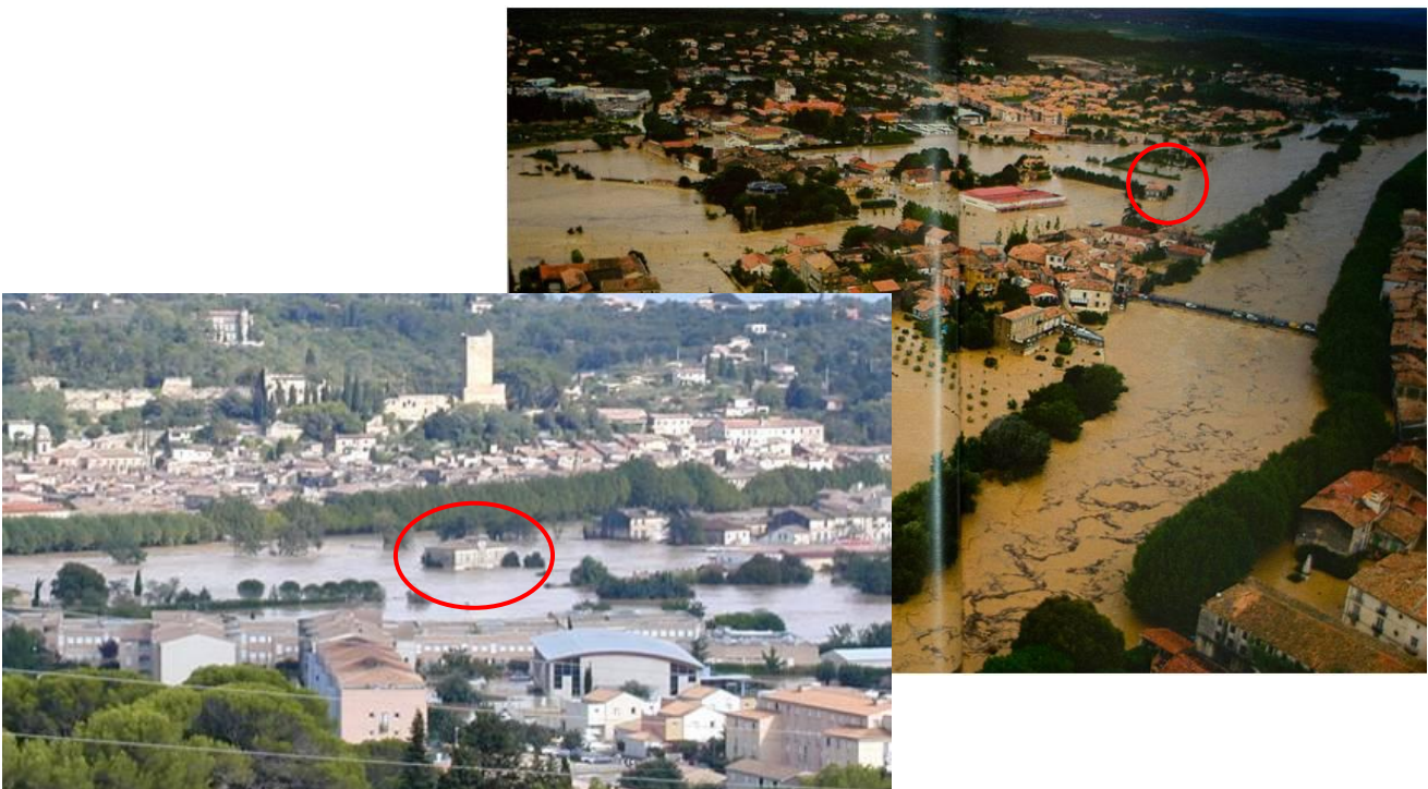
Figure 19 : Inondations lors de la crue de septembre 2002 (source : forums.infoclimat.fr)
