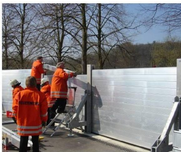
Figure 28 : Exemple de mur de protection anti-crue démontable (source : ETHI)
