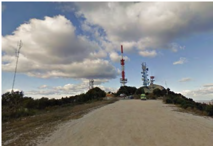
Zone de stationnement et antennes sur le Guidon du Bouquet (source : StreetView)
