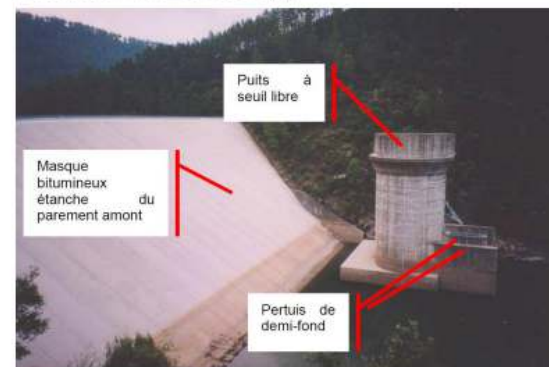
Vue des parements amont et de la tulipe du barrage de Sainte-Cécile (photo extraite de l'annexe « Note de contexte »).
