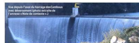
Les deux barrages, tous deux propriétés du Département, sont donc considérés comme faisant partie d'un seul et même complexe hydraulique.
