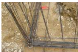
Nœud de chaînage - Continuité mécanique
