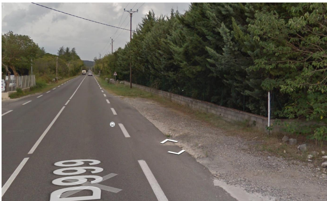
Illustration 2 : Photographie de la zone d'arrêt de bus dans le sens Le Vigan → Nîmes
