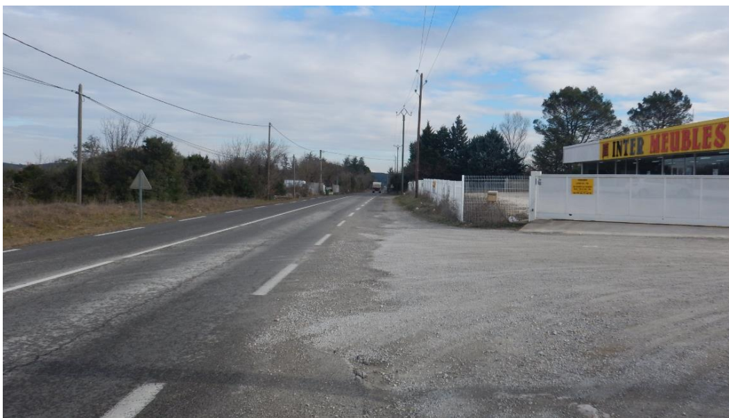
Illustration 1 : Photographies des accès directs des constructions du quartier Singla sur la RD999
