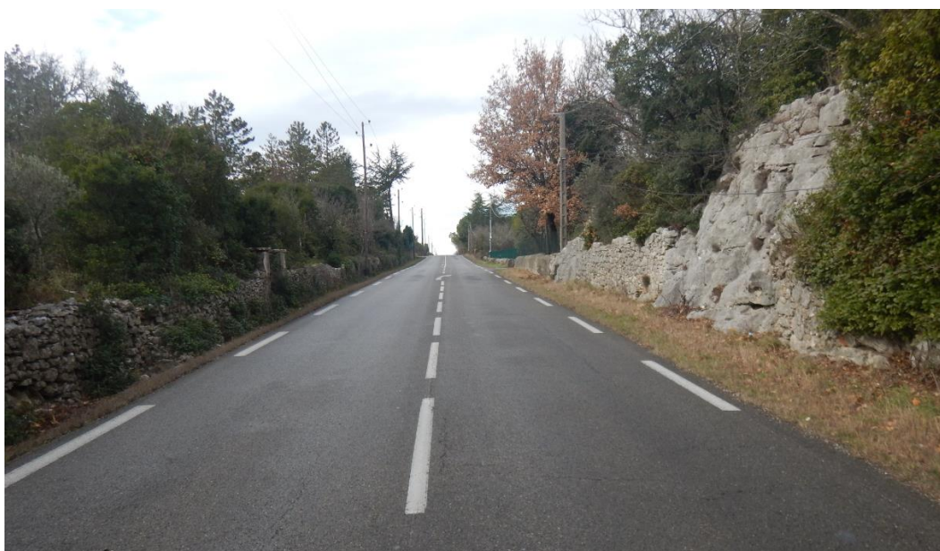
Illustration 3 : Photographie de la RD999 en situation actuelle montrant l'absence de trottoirs et d'accotements sécurisés
