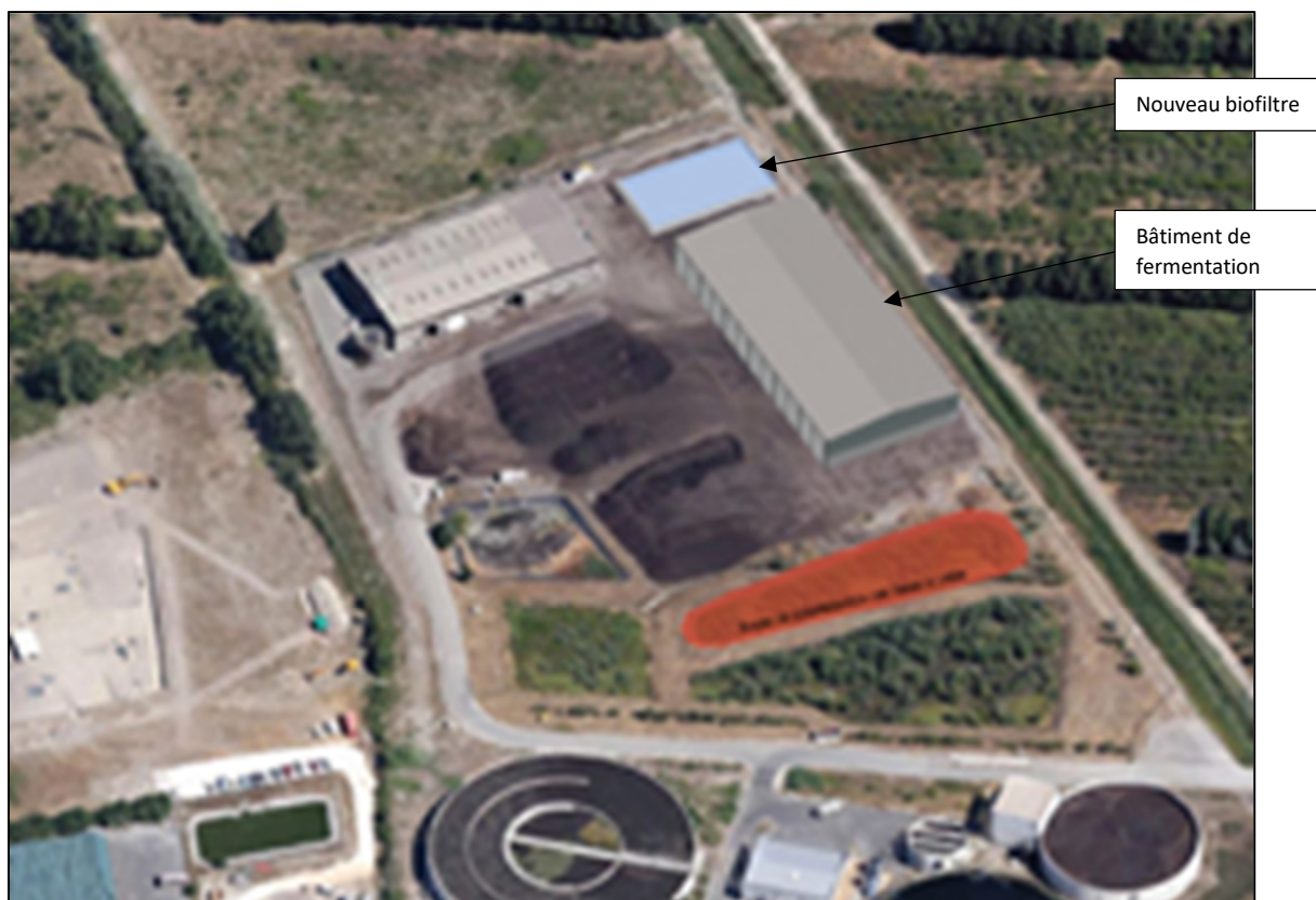
Figure 14 – Travaux menés sur la PFC
