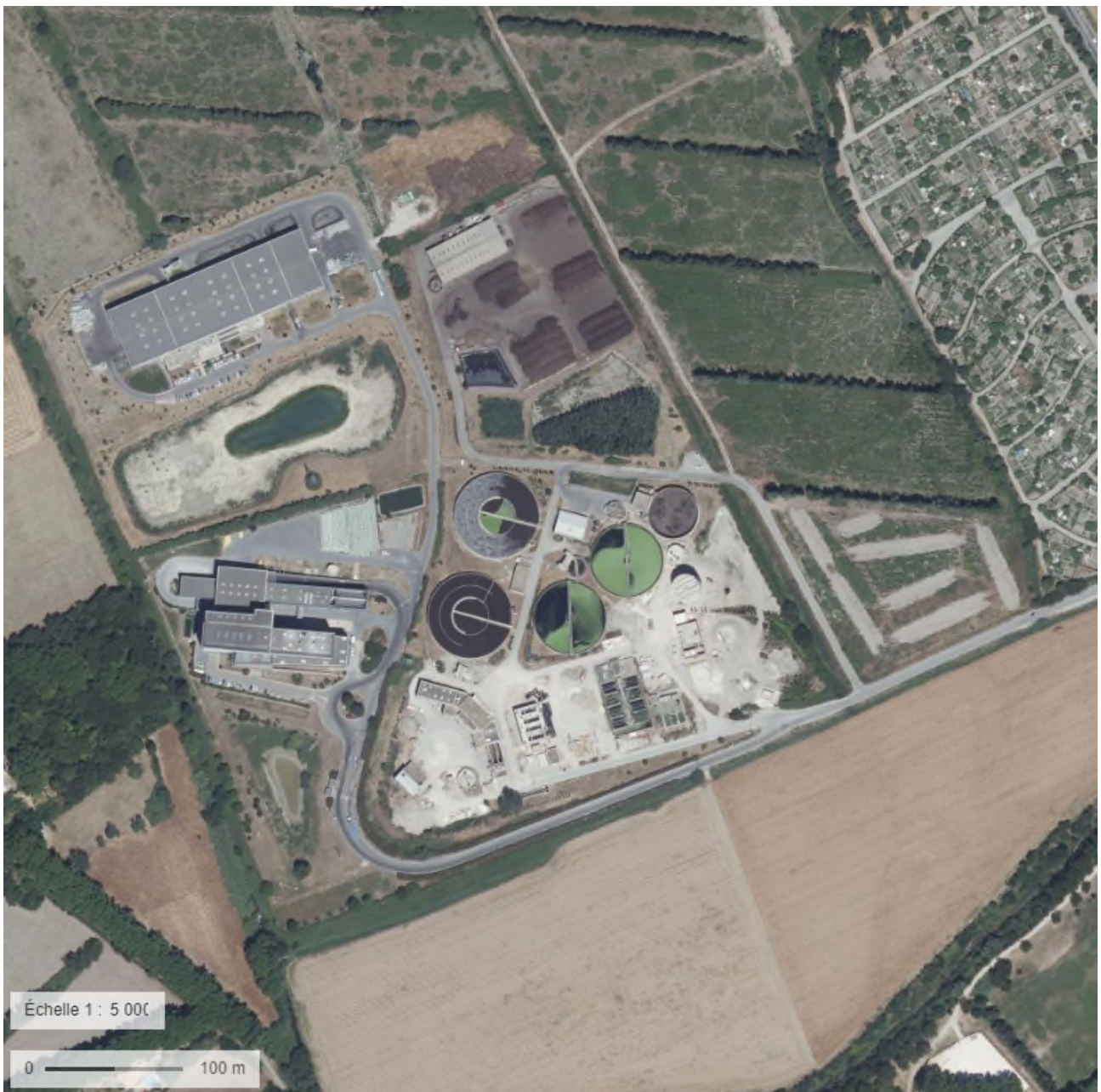
Figure 11 : Emprise de la zone d'étude – prise de vue juin 2021 (source : www.geoportail.gouv )
