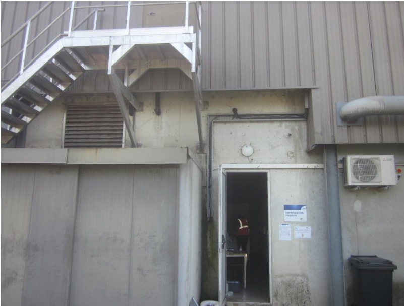
Figure 11: escalier d'accès au R+1
