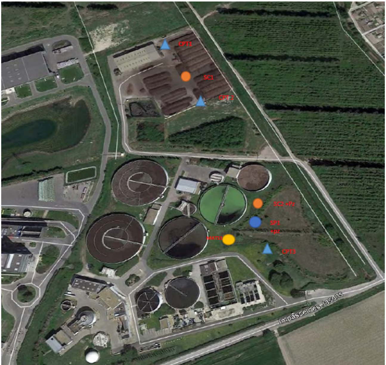
Figure 18 - Localisation des sondages carottés SC1 et SC2 (source : extrait du rapport Fondasol)
