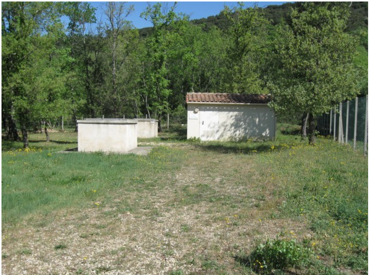
Captage « Sous la Forêt » : Forages Laffont F1 et F2
