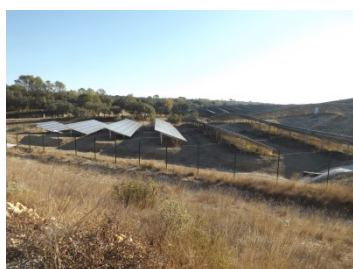
centrale photovoltaïque de Caveirac
