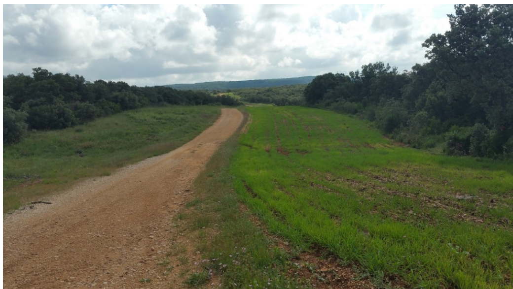
Piste avec bandes débroussaillées de sécurité sur 2 fois 10 mètres
