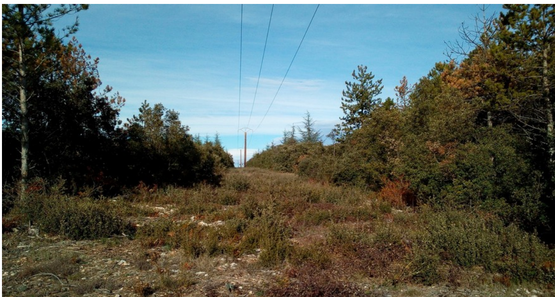
Débroussaillage sous une ligne ENEDIS
